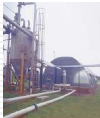
Biofiltro de 144 m 3 , que opera a la salida de la Planta de Tratamiento Anaeróbico de Aguas Residuales de SUCROMILES S.A. con eficiencias de remoción del 99% y cargas aplicadas de 2.3 gr H_2S / m 3 Rh.
